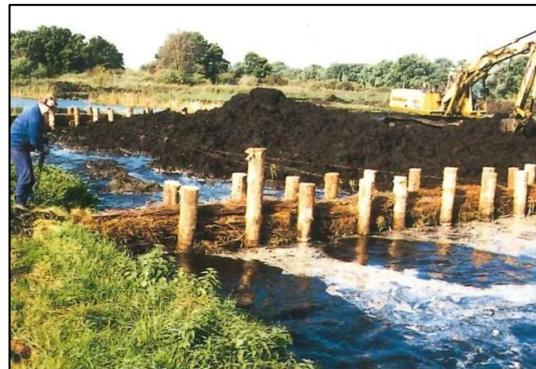
Einbau Faschinen und Verfüllung der Verbaue
