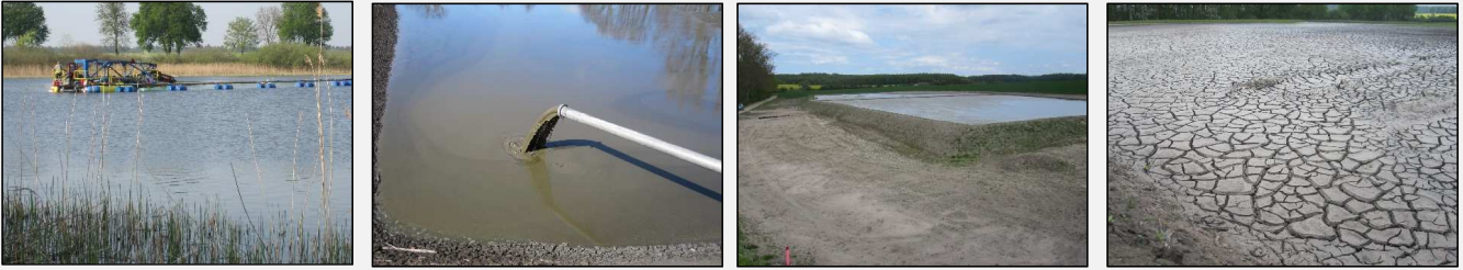
Abb.3: Sedimententnahme aus dem Wotrumer See durch Saugspülen in Flachspülfelder
