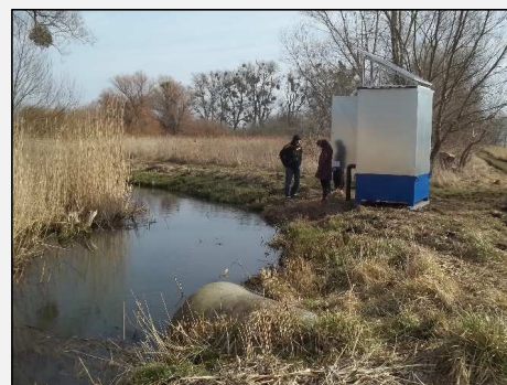
Abb.5: Phosphatfällanlage (Steuerteil, Vorratsbehälter, Pumpen und Energieversorgung) an der Kleinen Peene (Köthelbach)
