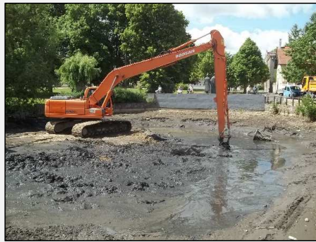
Abb.2: Baggerung von einem geschütteten Deich aus
