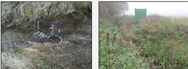
Abb.5: Phosphatfällanlage am Duckwitzer Graben
