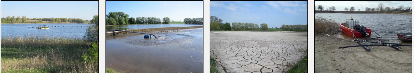
Abb.3: Anlegen von Sedimentfallen im Duckwitzer See durch Saugspülen, rechts: Ausbringen von PAC in den Sedimentfallen
