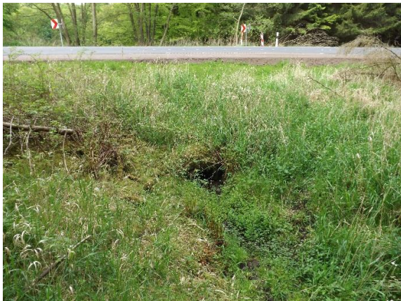
Abbildung 19: Rohrdurchlass unter der L 303 im Nationalpark (Foto: Tschakert 2016)
