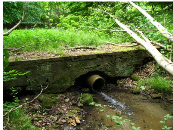
Abbildung 26: Rohrdurchlass 25 m unterhalb des Teiches am Kollicker Bach (Maßnahmen-Nr.133_1) (Foto: Thiele 2017)
