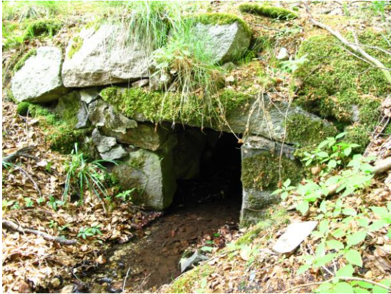
Abbildung 23: Durchlass mit Steinfassung am Kollicker Bach (Maßnahmen-Nr. 111_1). Eine Substratdurchlässigkeit scheint gegeben. (Foto: Thiele 2017)
