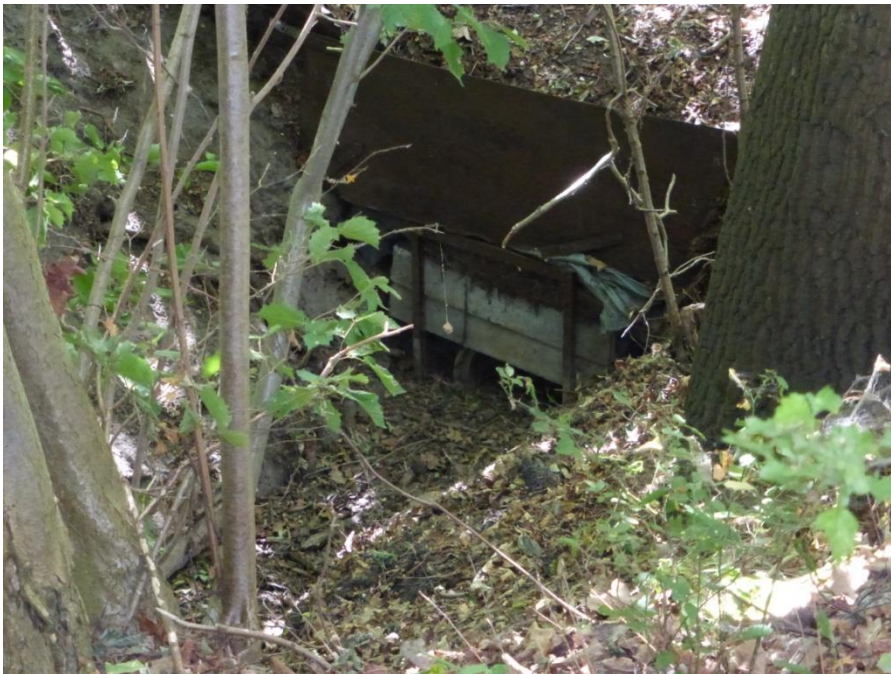
Abbildung 15: Verrohrung unter dem Hohenfelder Weg (Zufahrt zum Ferienlager), Foto: Christin Geisbauer (StALU VP 2018)
