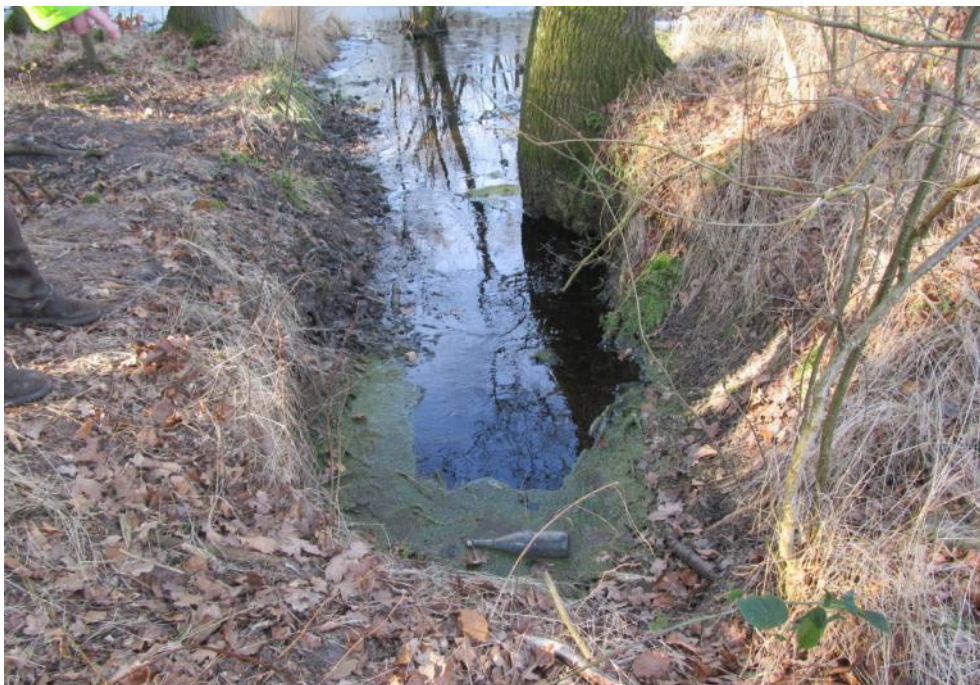
Abbildung 13: vorhandene Verbauung am Abfluss des Jeesser Moores (2018)
