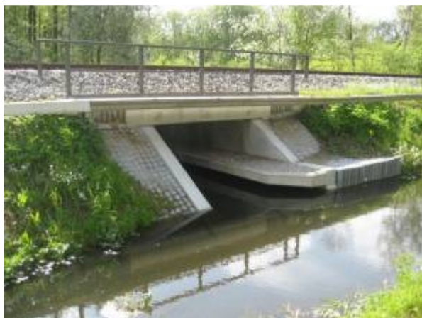
Abb. 25: Ersatzneubau Durchlass L62
