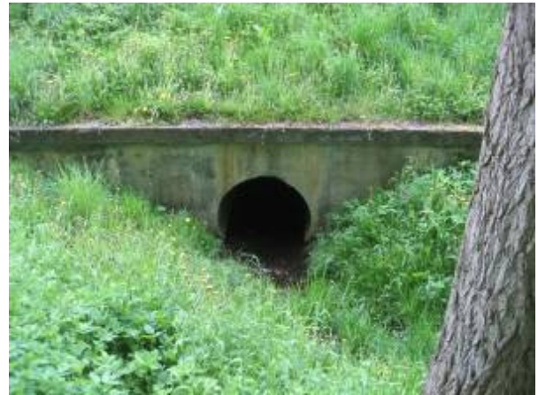
Abb. 24: Durchlass der B109 am Karlsburger Holz
