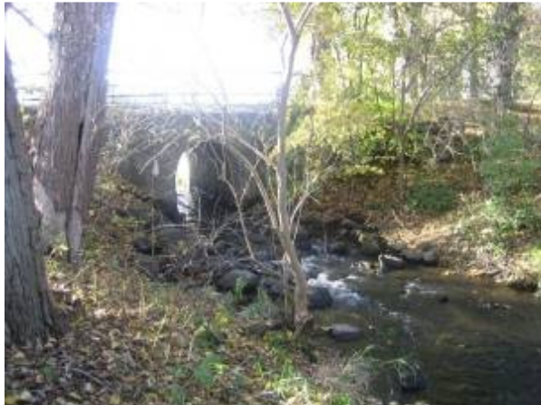
Abb. 27: Brebowbach - Durchlass der K30 in Wehrland
