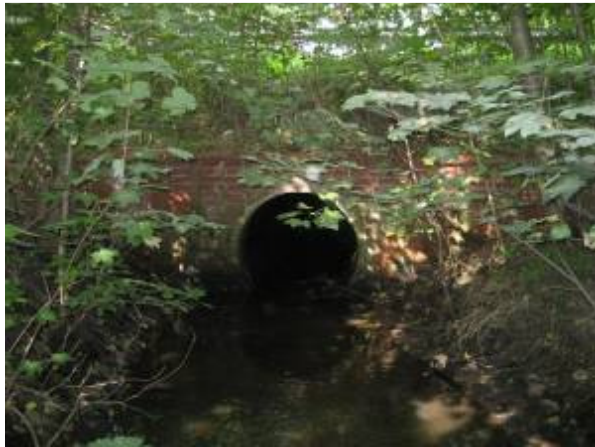
Abb. 23: Durchlass Prägelsbach der L26
