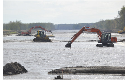
Vorbereiten des Untergrundes für die Sandeinspülung
