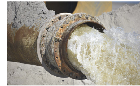
Das Sediment wird eingespült und verdichtet
