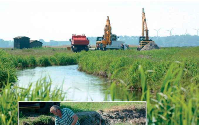
Die Bauarbeiten am Boddendeich haben begonnen und die ersten Entwässerungsgräben werden umverlegt.
