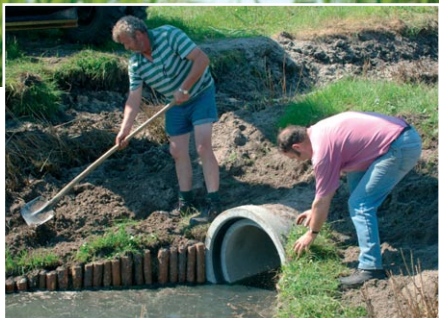
Die Bauarbeiten am Boddendeich haben begonnen und die ersten Entwässerungsgräben werden umverlegt.
