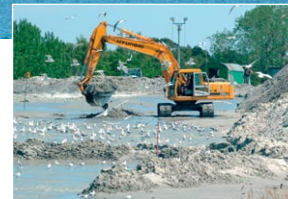
Seesand für den Boddendeich wird aus der Ostsee entnommen und lagert in einem bauzeitlichen Spülfeld
