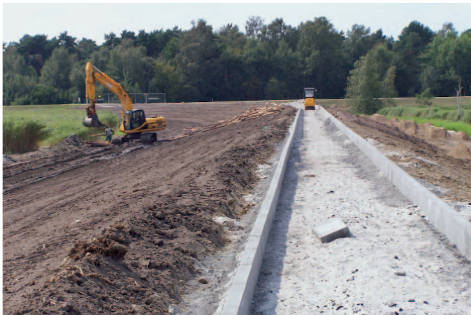
Bauarbeiten am Boddendeich
