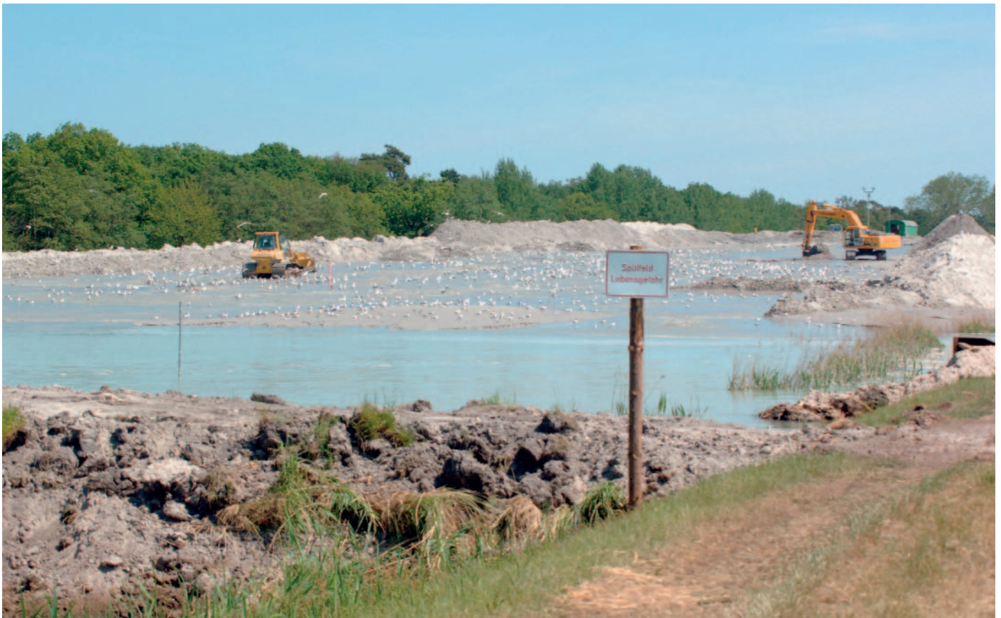
Einspülen von Seesand in ein temporäres Spülfeld
