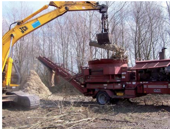
4 Baufeldfreimachung auf dem künftigen Bodenlagerplatz © Anne Ziegler
