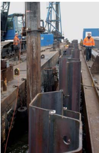
5 Arbeiten am Bauanleger © Joachim Kloock
