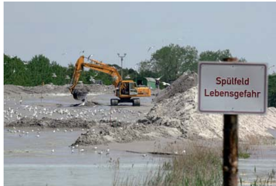
6 Einspülen von Seesand für den Deichbau © Joachim Kloock
