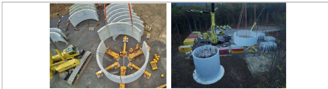
Abbildung 6 Turm des Typs TCS164B, Errichtung des Drittelschalen (links) und der Sektion (rechts)
