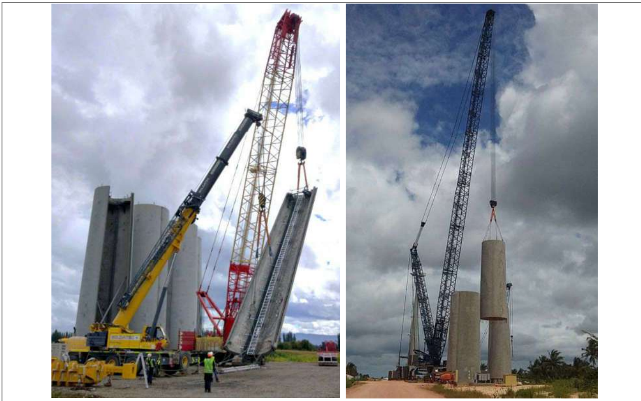
Abbildung 5 Vormontage (links) und Montage (rechts) von Turmsektionen des Nordex Betonturm
