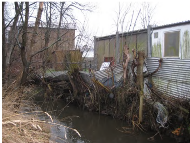
2013 Frühjahr Swinow oberhalb der ehemaligen Mühle (vorher)
