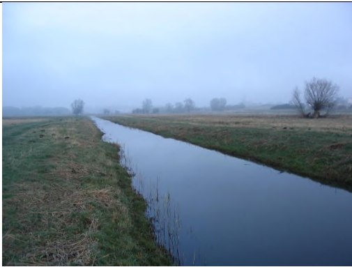
2011 Swinow oberhalb Brücke Liebenthal (vorher)
