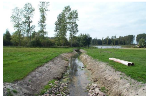
(1) Entrohrung am Ablauf des Pelsiner Sees Nachher: Offener Gewässerlauf (2011)
