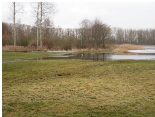
(1) Entrohrung am Ablauf des Pelsiner Sees Vorher: Verrohrung mit Schadstellen (Trichterbildung) am Pelsiner See (2010))
