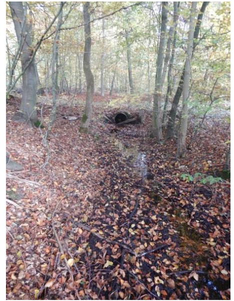
Abb. 9: Forstwegquerung von TF 003 mittels Rohrdurchlass
