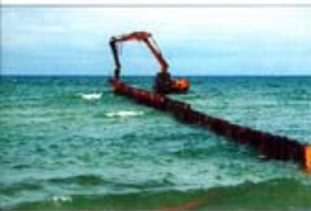
Bühne aus Tropenholz wird gerammt
